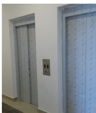
Električni putnički liftovi: Q = 630 kg, n = 9/9 ili n = 8/8 8 kom Q = 450 kg, n = 9/9 ili n = 8/8 5 kom Q = 1000 kg, n = 9/9 3 kom
