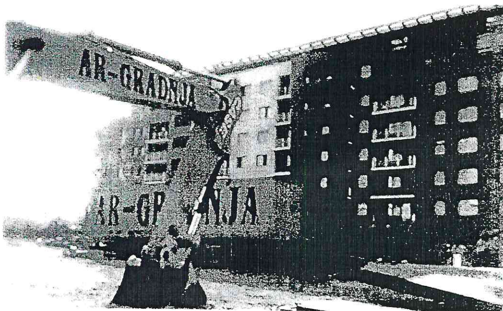
1. Fotografija površine prilikom izvođenja radova Direkcije za građevinsko zemljište
