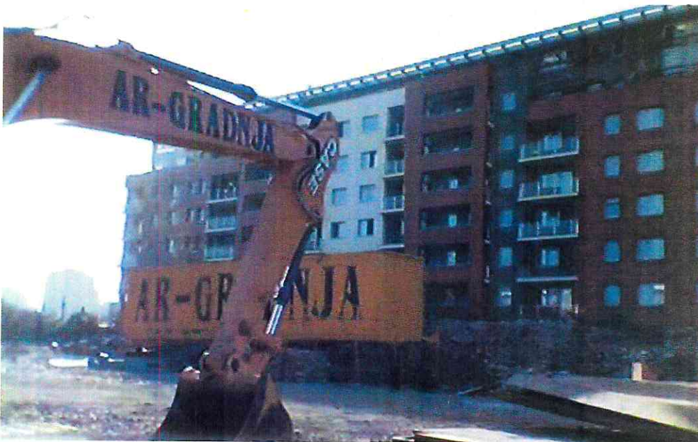
1. Fotografija površine prilikom izvođenja radova Direkcije za građevinsko zemljište
